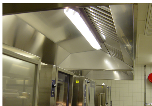
Filterhus i kåpa över ugn. Det är viktigt att överhänget är tillräckligt och att filterhuset monteras i framkanten av kåpan.
