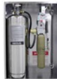
Släckmedelsbehållarna tar liten plats och monteras i rostfria skyddsskåp som placeras vid tak för att frigöra bänk- och golvutrymme
