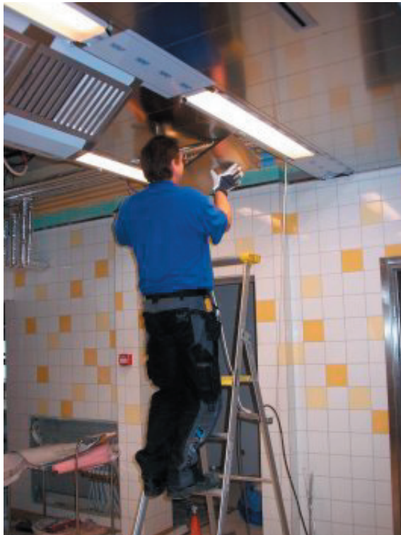
Inläggning av takpaneler
