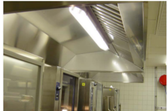
Filterhus i kåpa över ugn. Det är viktigt att överhänget är tillräckligt och att filterhuset monteras i framkanten av kåpan.
